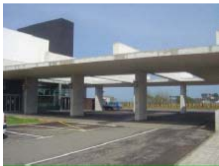
Foto 1. Marquesina de acceso a una UUH
